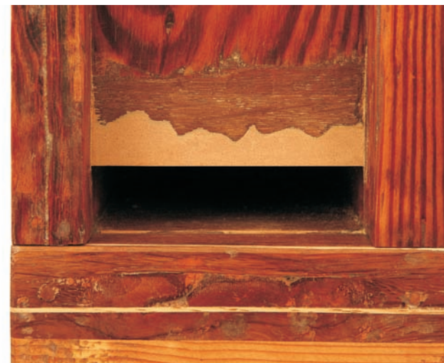
Detail píšťaly G Octavbassu po restaurování
